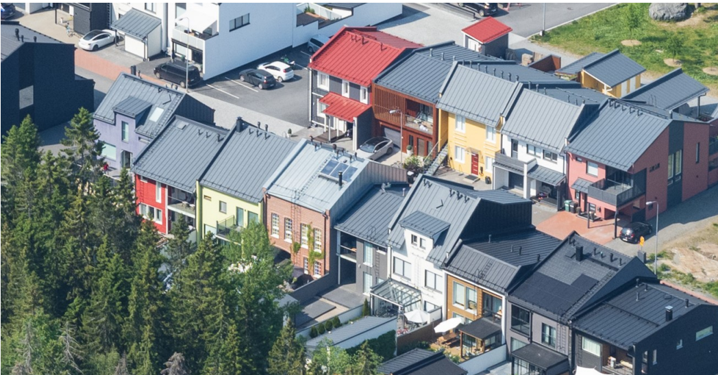
Kuva 3. Pirkkala, Tuohikorpi. Kun kattokulmia ja räystäskorkeuksia ei määrätä asemakaavalla, syntyy monimuotoista rakennetta ja vaihtelevaa kattomaailmaa
